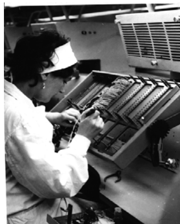
Рис. 11.11. Рабочее место жгутового монтажа
