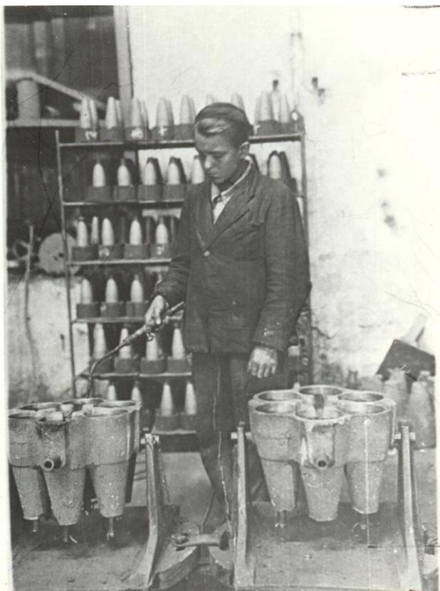
*Подготовка форм для отливки корпусов мин*
