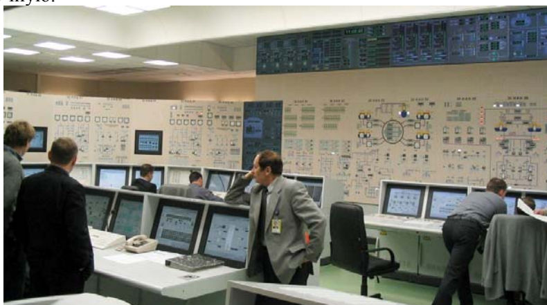
Рис. 1. Общий вид БПУ 3 энергоблока Калининской АЭС.
