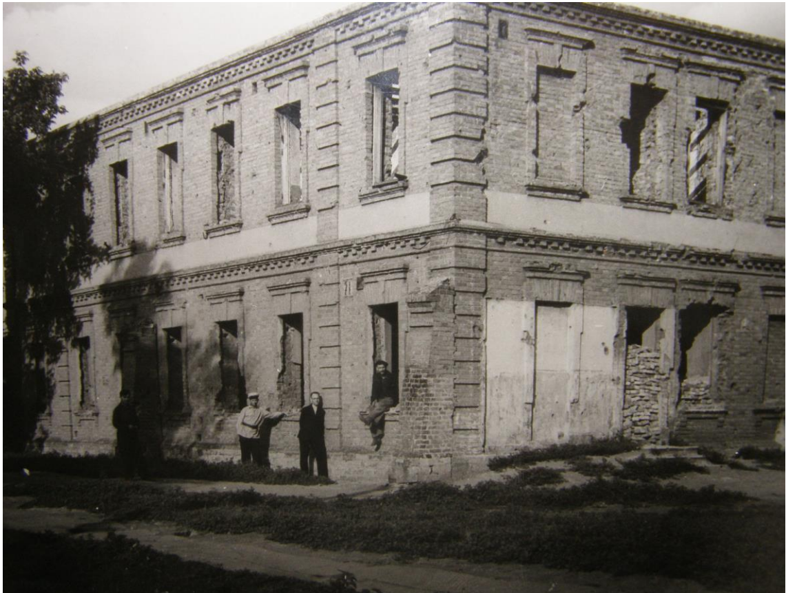
Разрушенное общежитие Тихорецкого ж/д техникума
